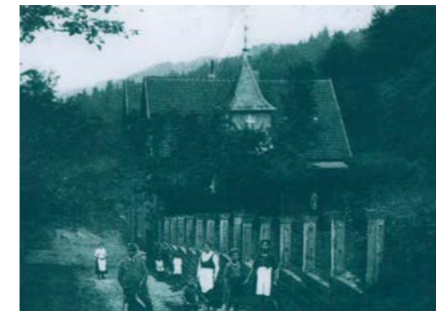
Kneipe „Wilden Jäger“ vor der Sanierung
